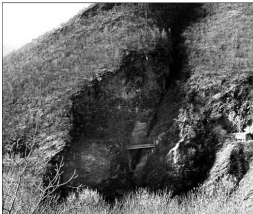
Fig. 1: Die Brücke Val d'Infern als Verbindung zweier Tunnel quert eine geologische Störzone.
