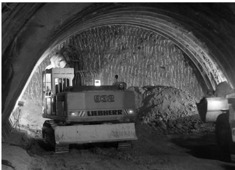
Fig. 5: Excavation dans la moraine grise dite «moraine béton».
