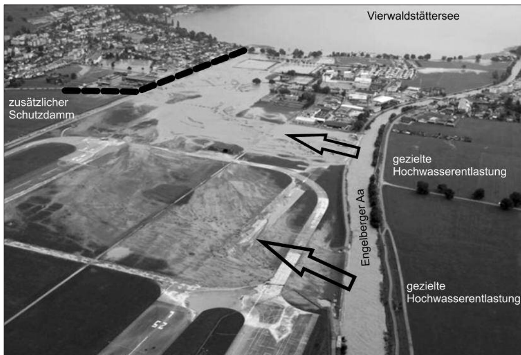
Fig. 5: Gezielte Hochwasserentlastung an der Engelberger Aa bei Buochs (Nidwalden).
